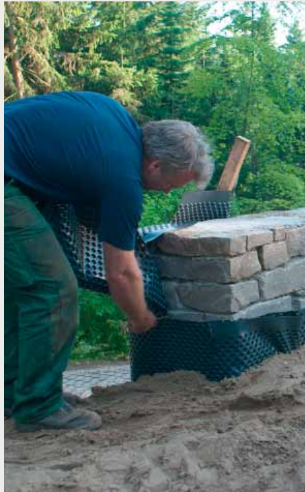
Wasser von Mauern abhalten: Um Steig-, Sicker- und Stauwasser abzuleiten wurde eine Noppenbahn im erdberührten Bereich verlegt. | Foto: Verena Sprung
