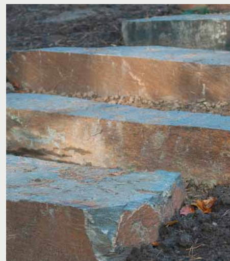
Spannungsvoller Farbkontrast: Rustikale Treppenanlage mit Blockstufen aus Fruchtschiefer | Foto: Verena Sprung
