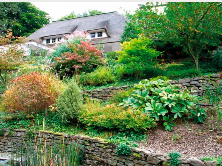
Gefälle natürlich gestaltet: Mehrere Trockenmauern fangen den Höhenunterschied von rund neun Metern ab. | Foto: Erwin Bauer
